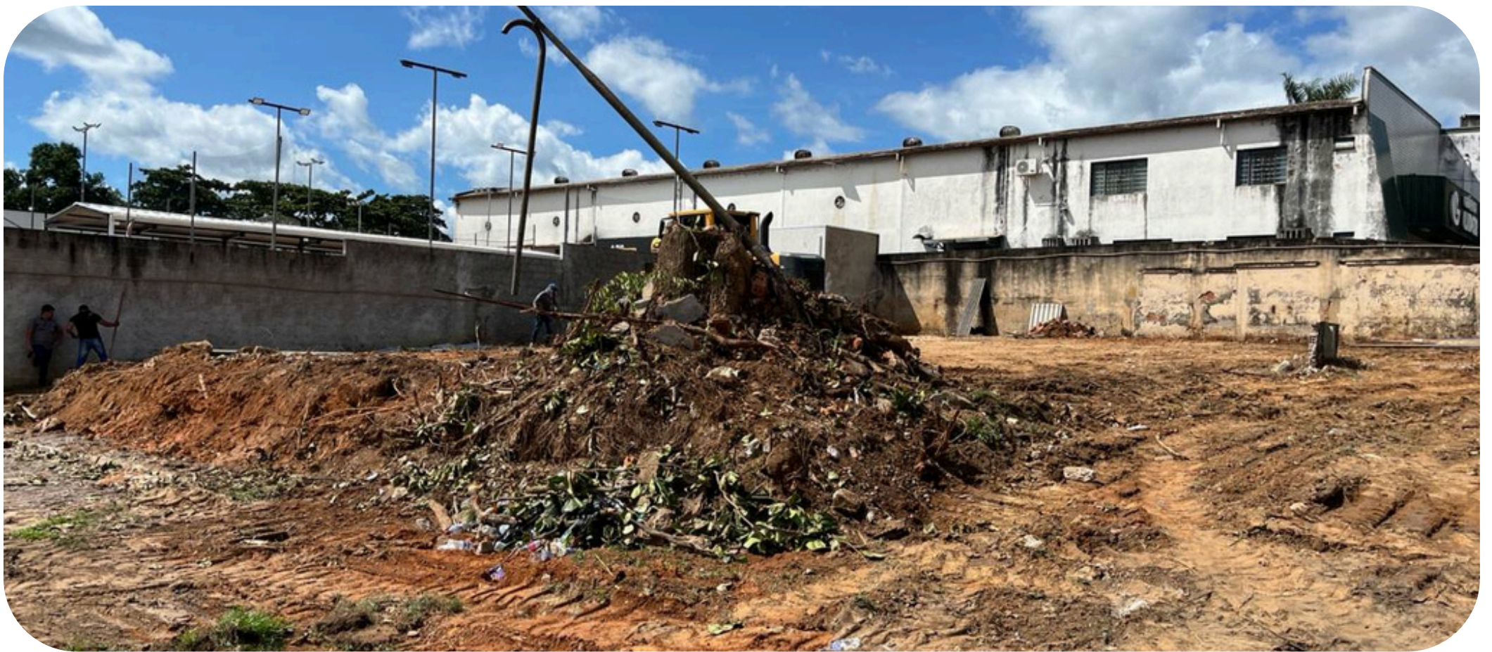
Imagem 03 - Limpeza mecanizada terreno e qualidade do terreno
