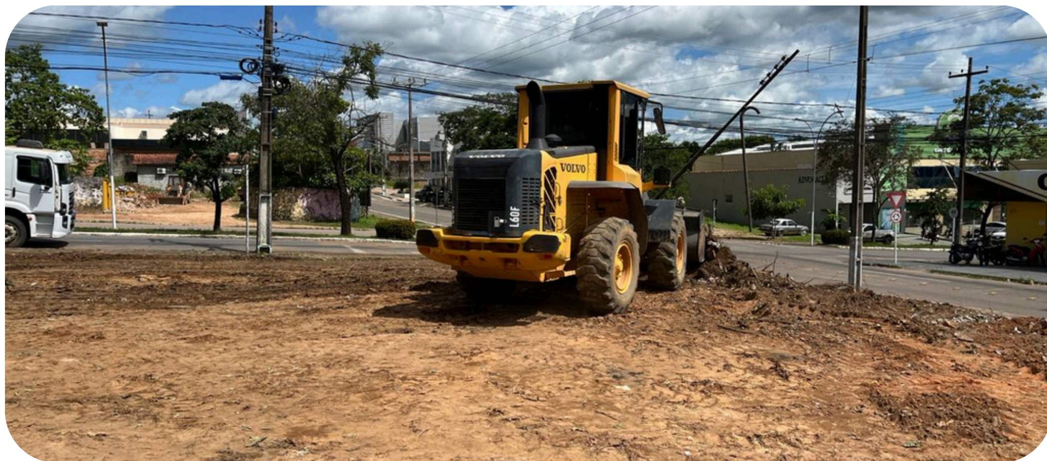
Imagem 01 - Limpeza mecanizada terreno
