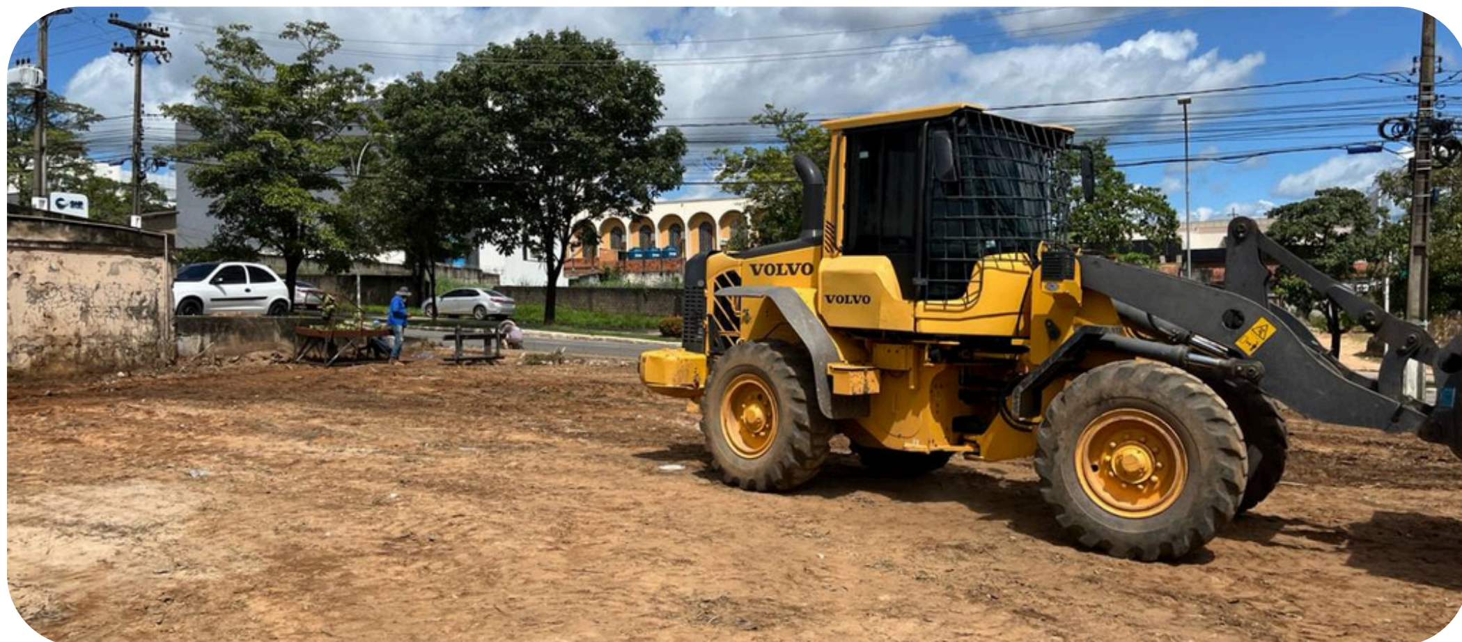
Imagem 02 - Limpeza mecanizada terreno
