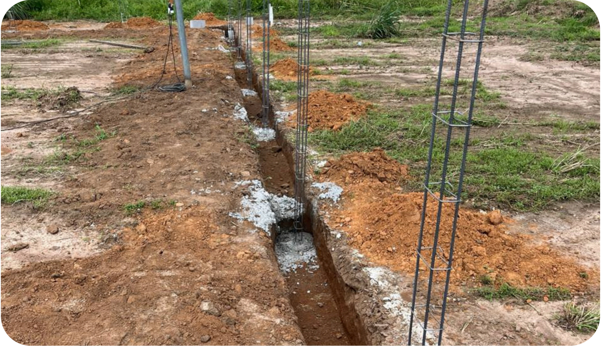
Imagem 03 - detalhes alinhamento e escalonamento
