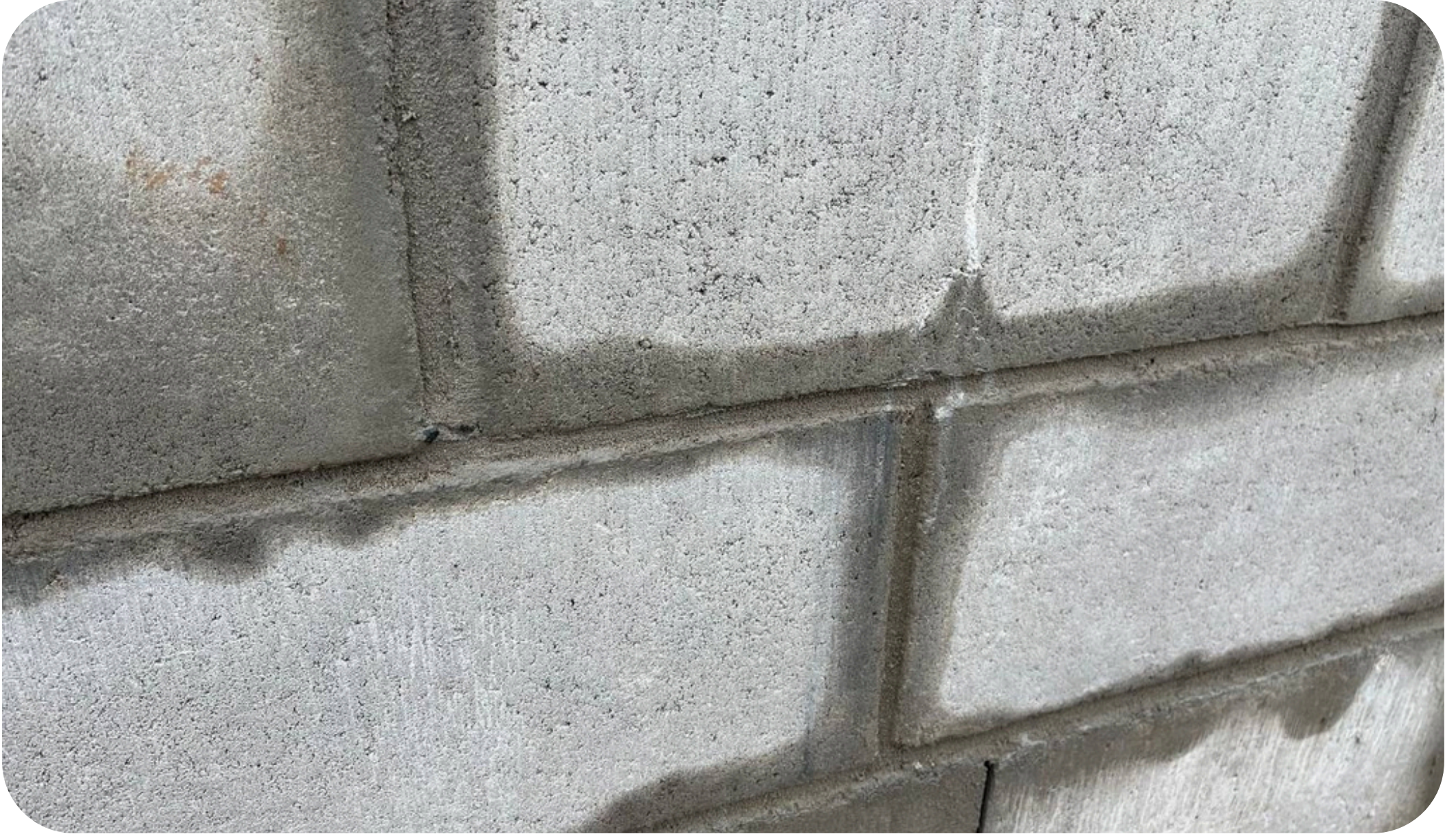
Imagem 03 - detalhe argamassa assentamento e acabamento estético
