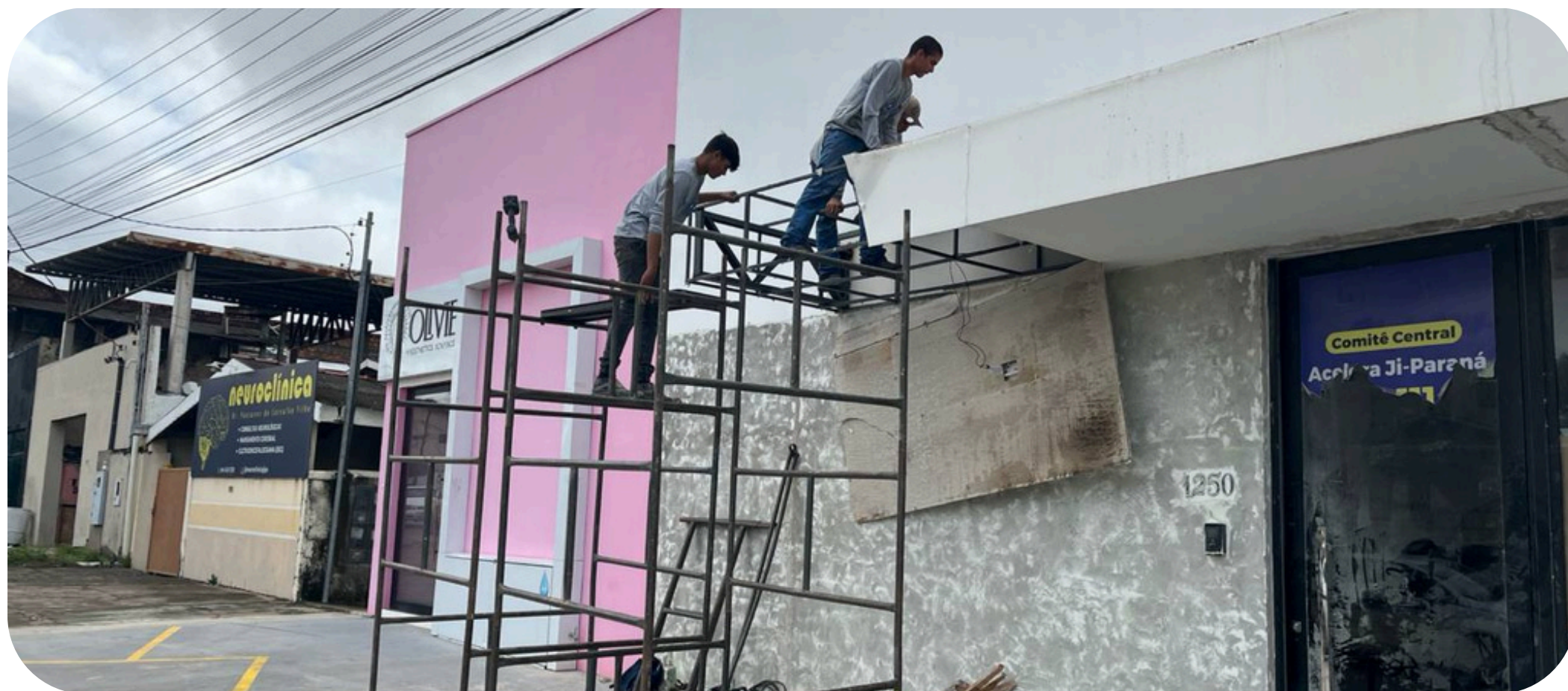
Figura 01 - Montagem andaimes e início do deslocamento
