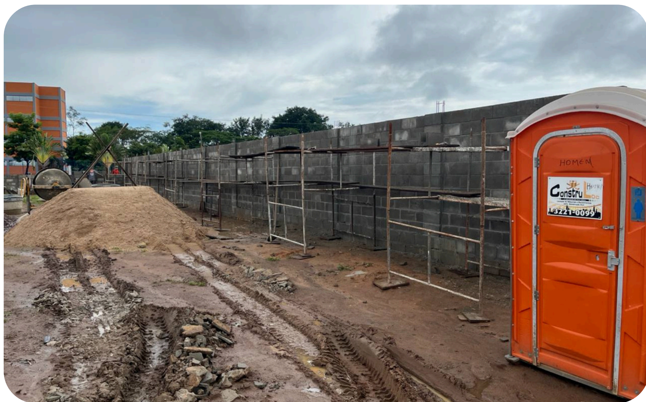
Imagem 01 - muro lado direito sendo finalizado assentamento
