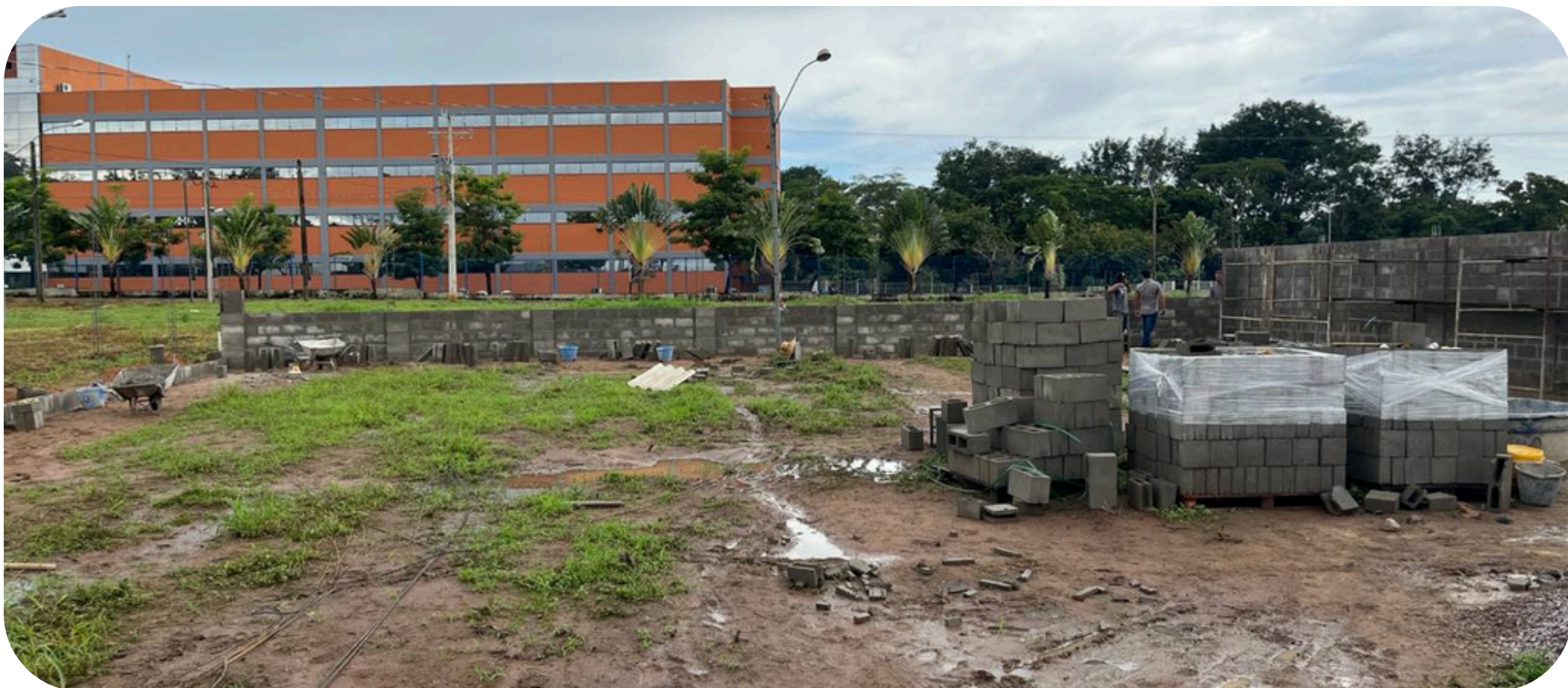
Imagem 02 - Perspectiva geral da obra
