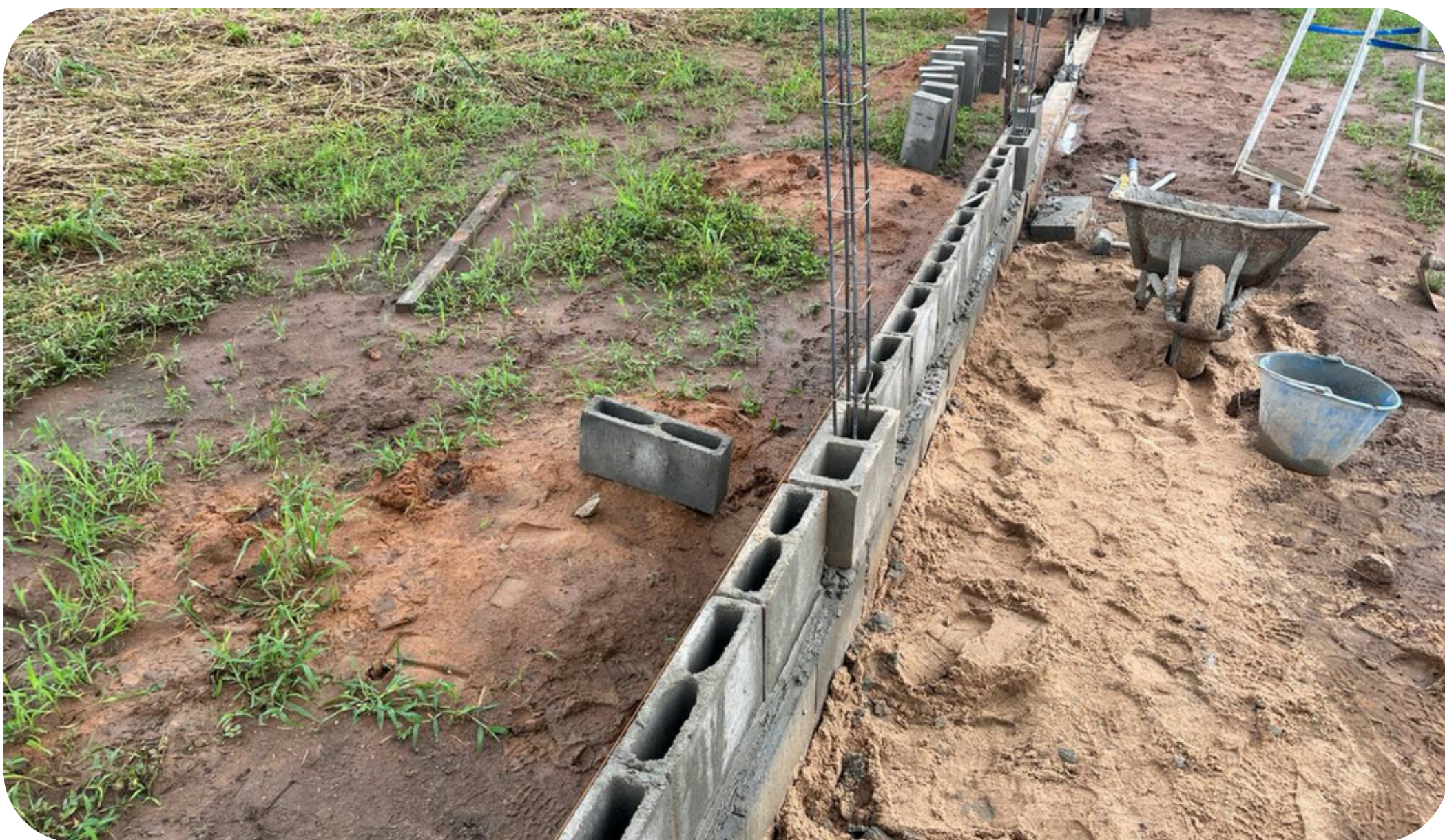
Imagem 03 - muro lado esquerdo em processo de assentamento
