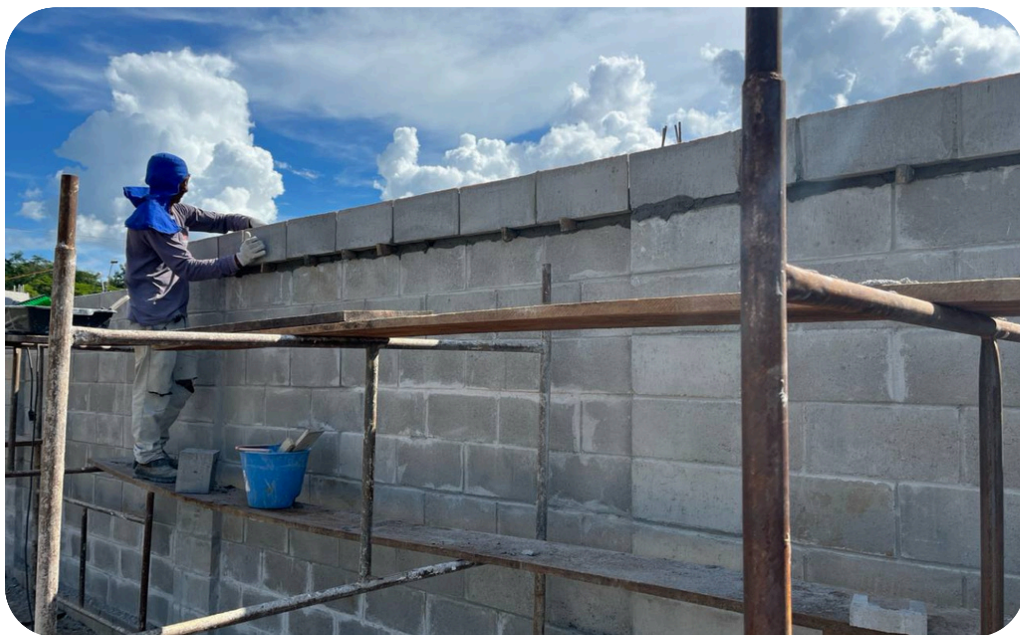
Imagem 01 - muro lado direito sendo finalizado assentamento
