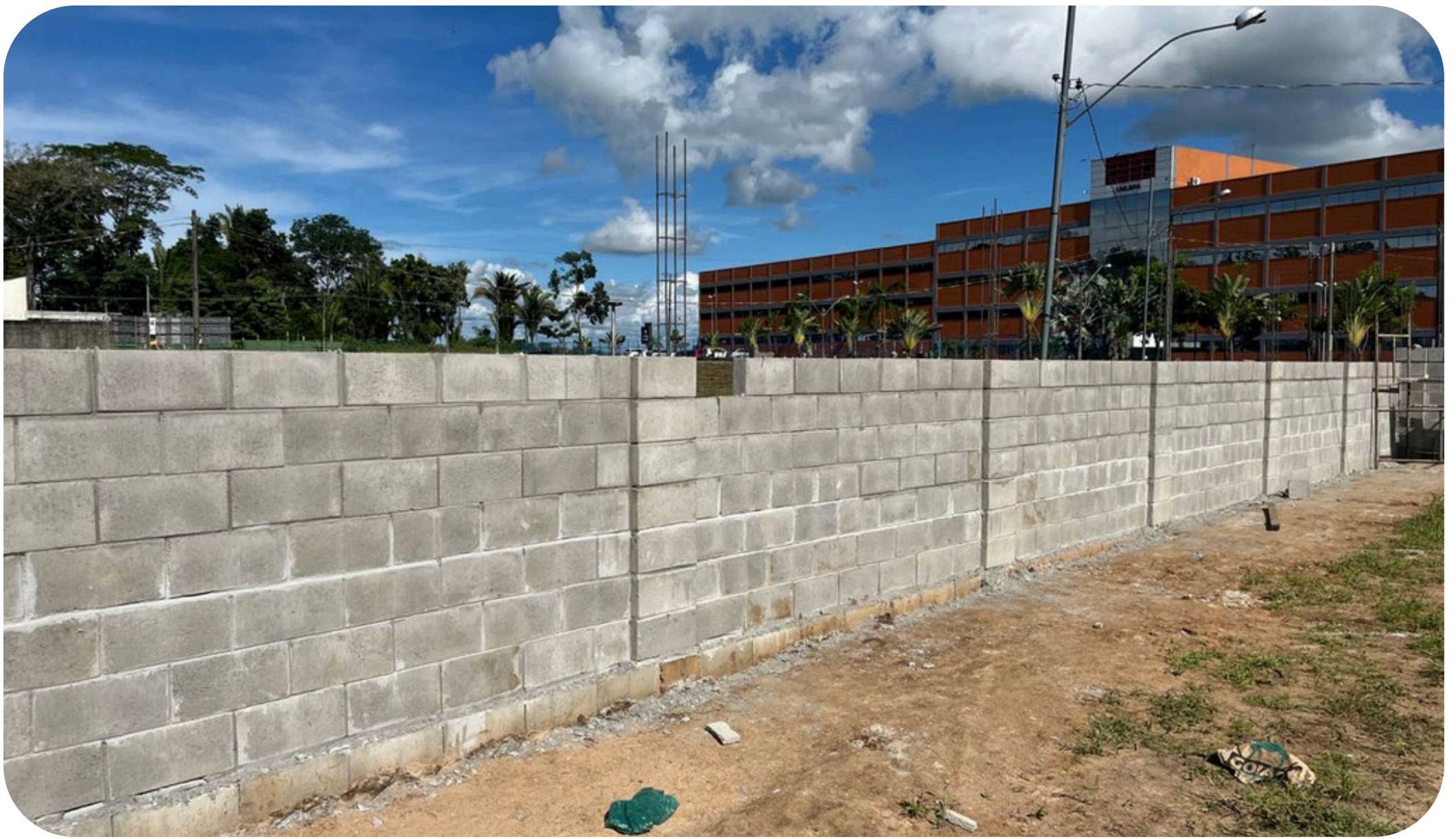
Imagem 04 - muro lado esquerdo em processo de assentamento
