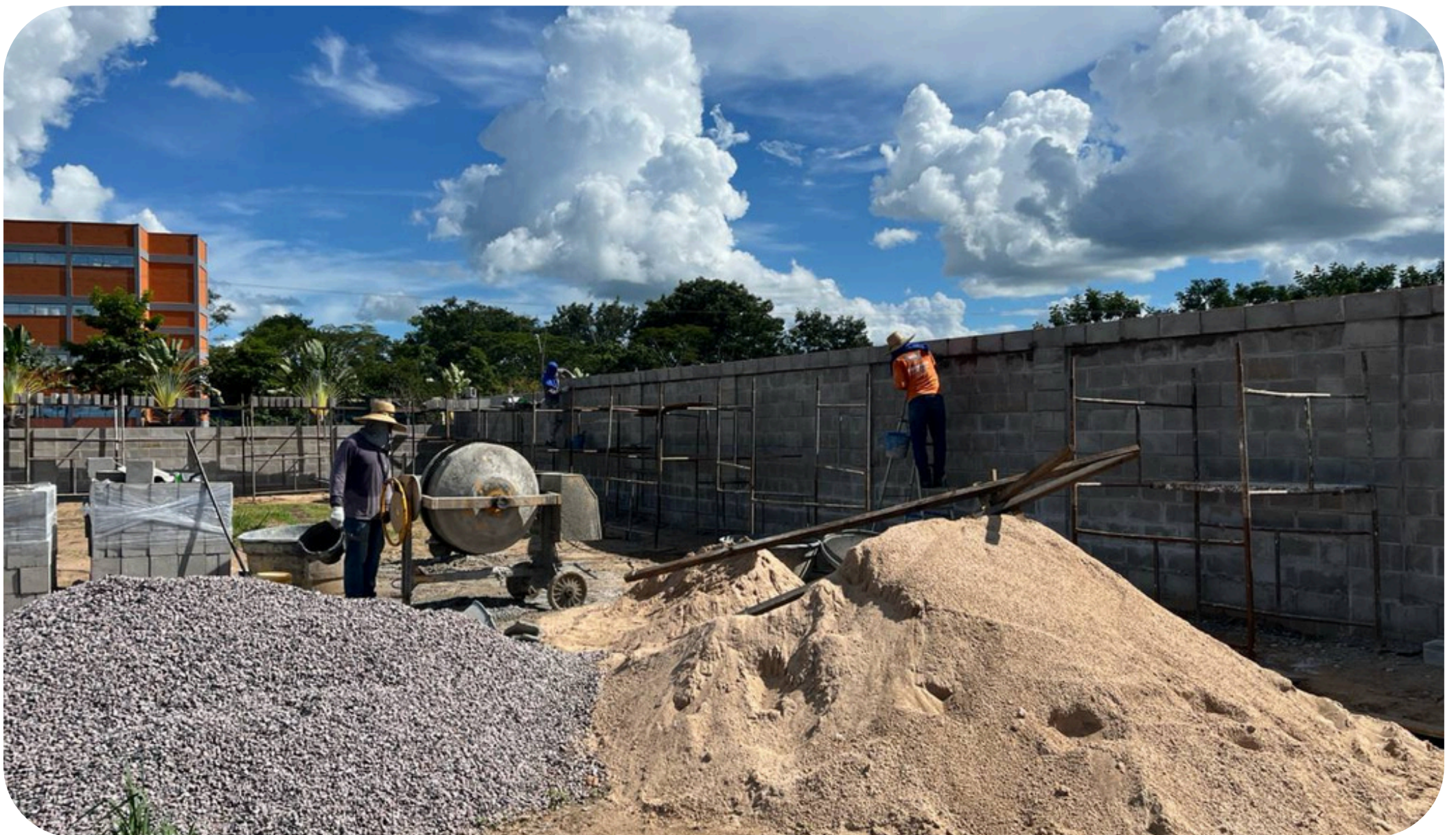
Imagem 03 - muro lado direito em processo de finalização assentamento
