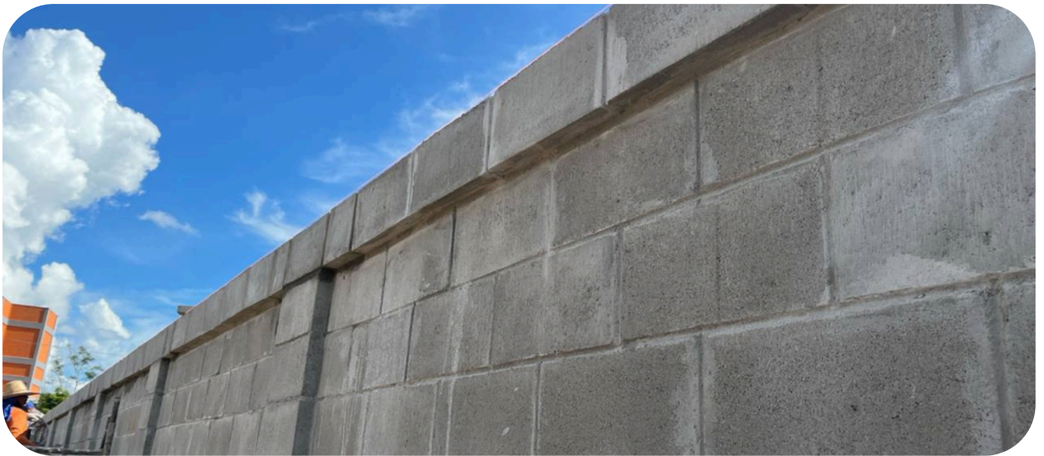
Imagem 02 - detalhes do muro
