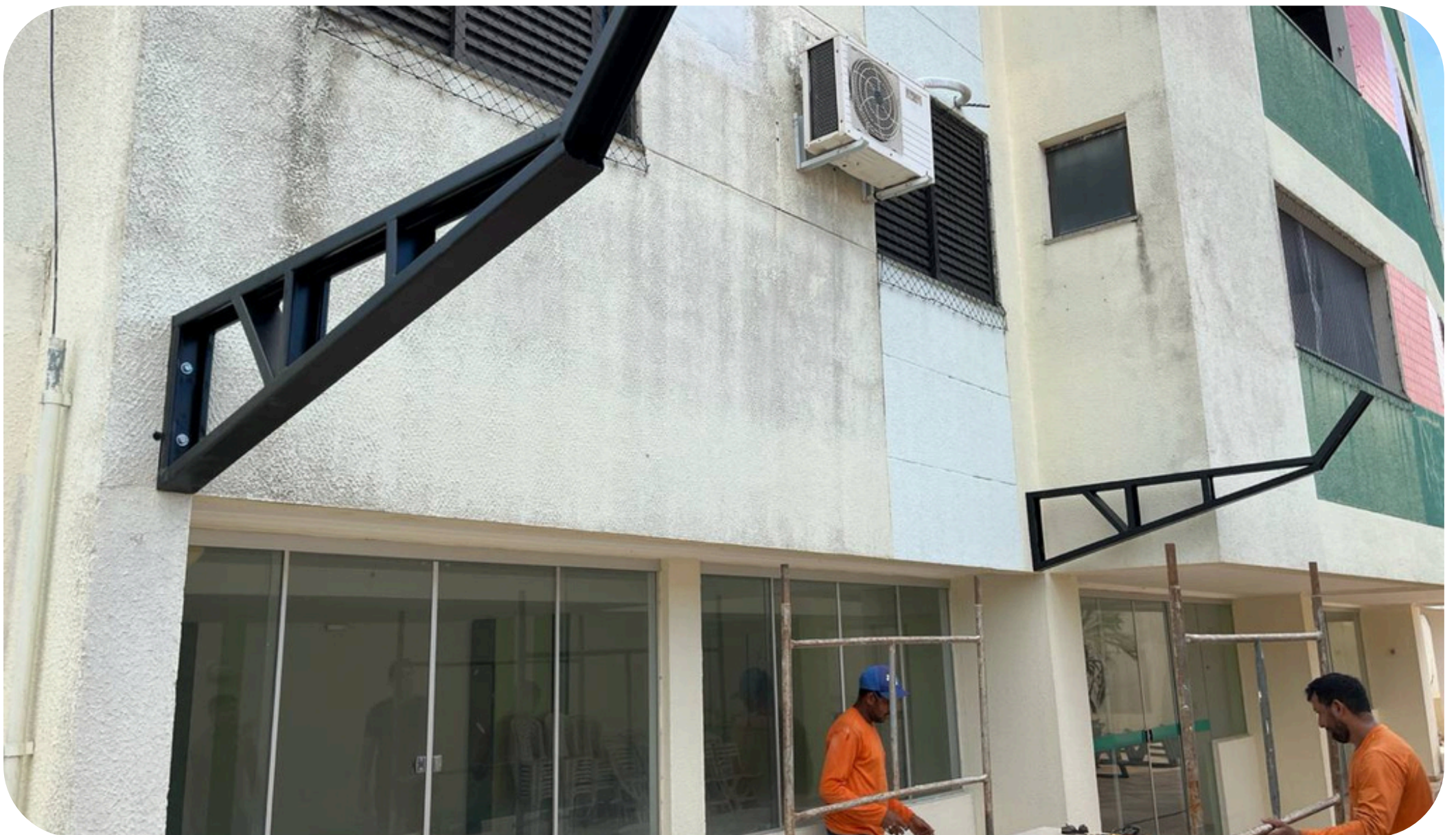
Imagem 03 - Instalação estrutura principal bandeja de proteção
