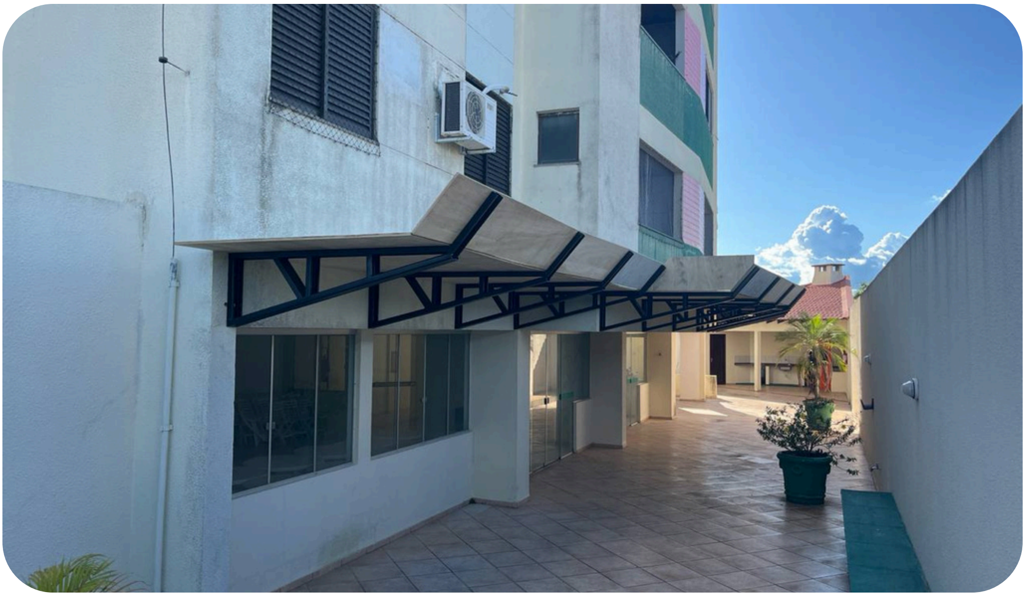
Imagem 04 - Instalação estrutura principal bandeja de proteção
