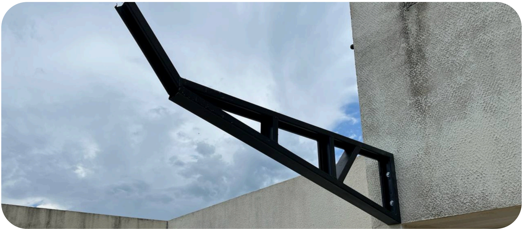
Imagem 02 - Instalação estrutura principal bandeja de proteção
