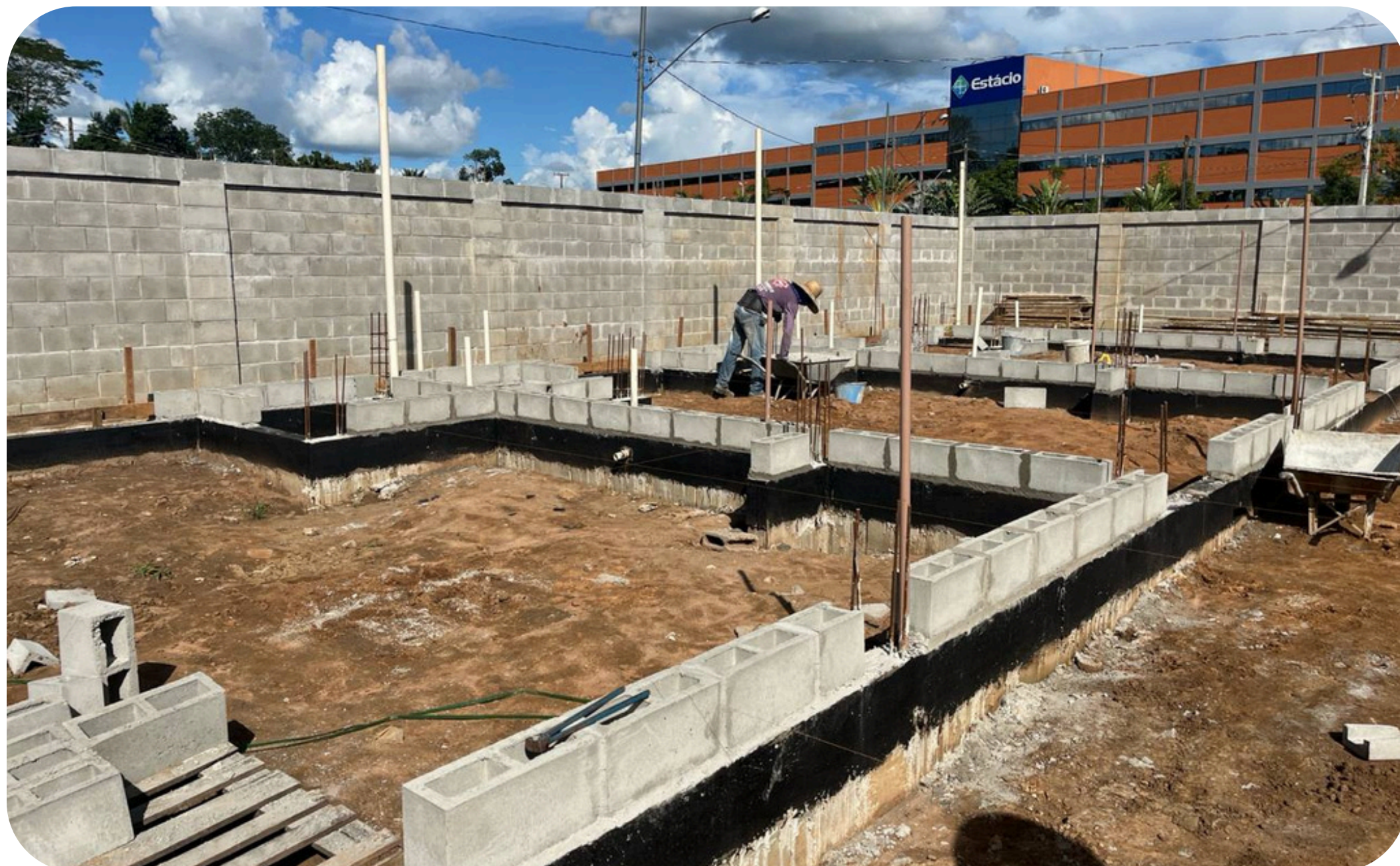
Imagem 01 - Assentamento de alvenaria em blocos de concreto
