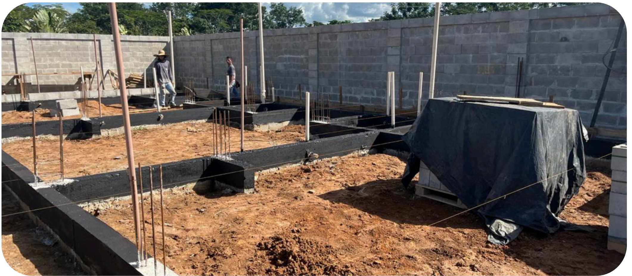
Imagem 02 - Passagens tubulações hidrossanitarios e esperas
