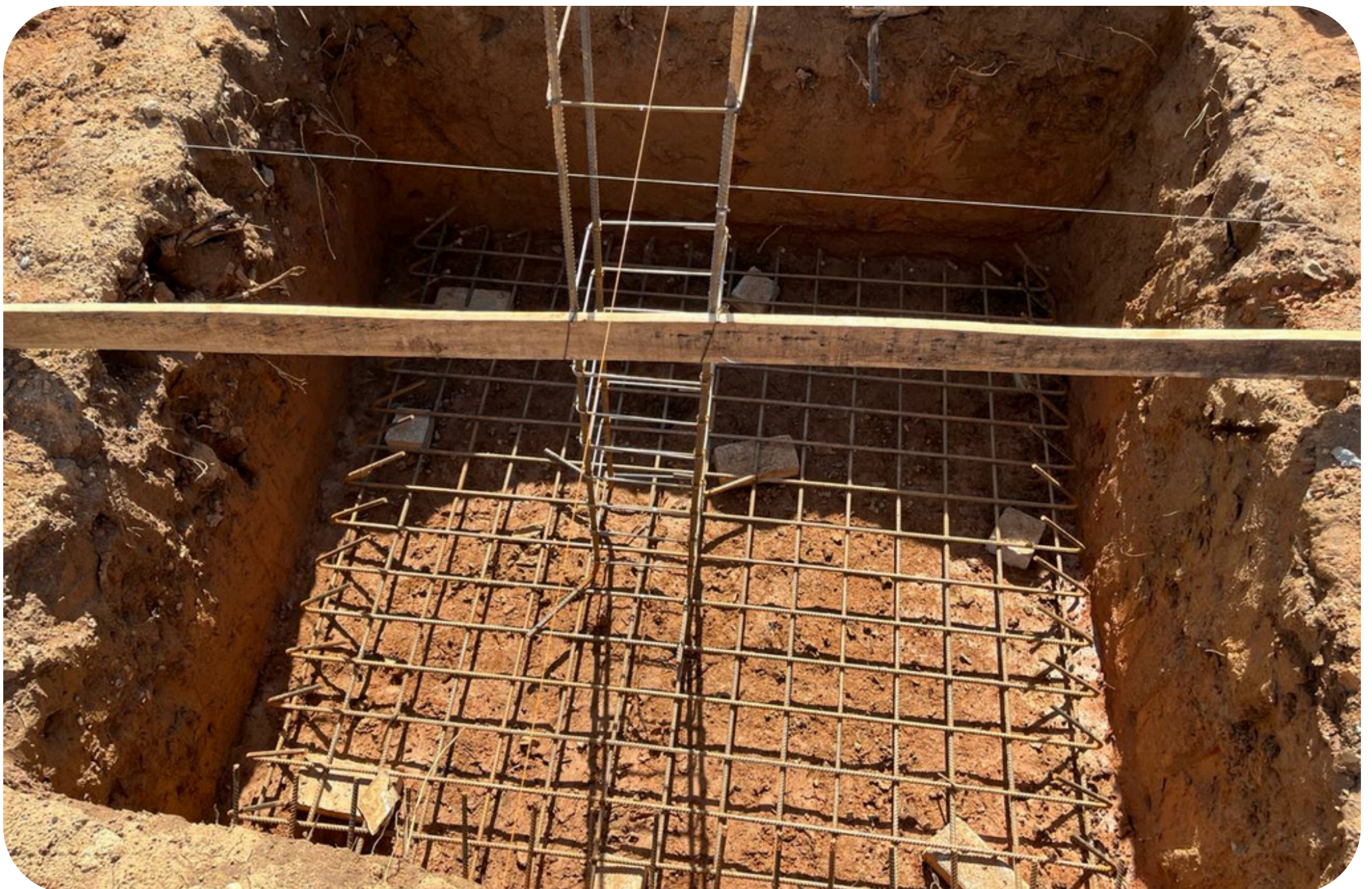
Imagem 04 - Detalhes do preparo das armaduras e espaçamentos antes da concretagem
