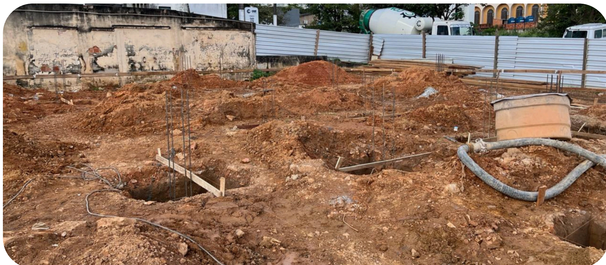
Imagem 02 - Concretagem sapatas
