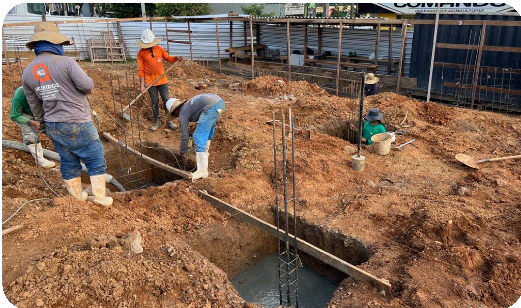
Imagem 01 - Concretagem sapatas
