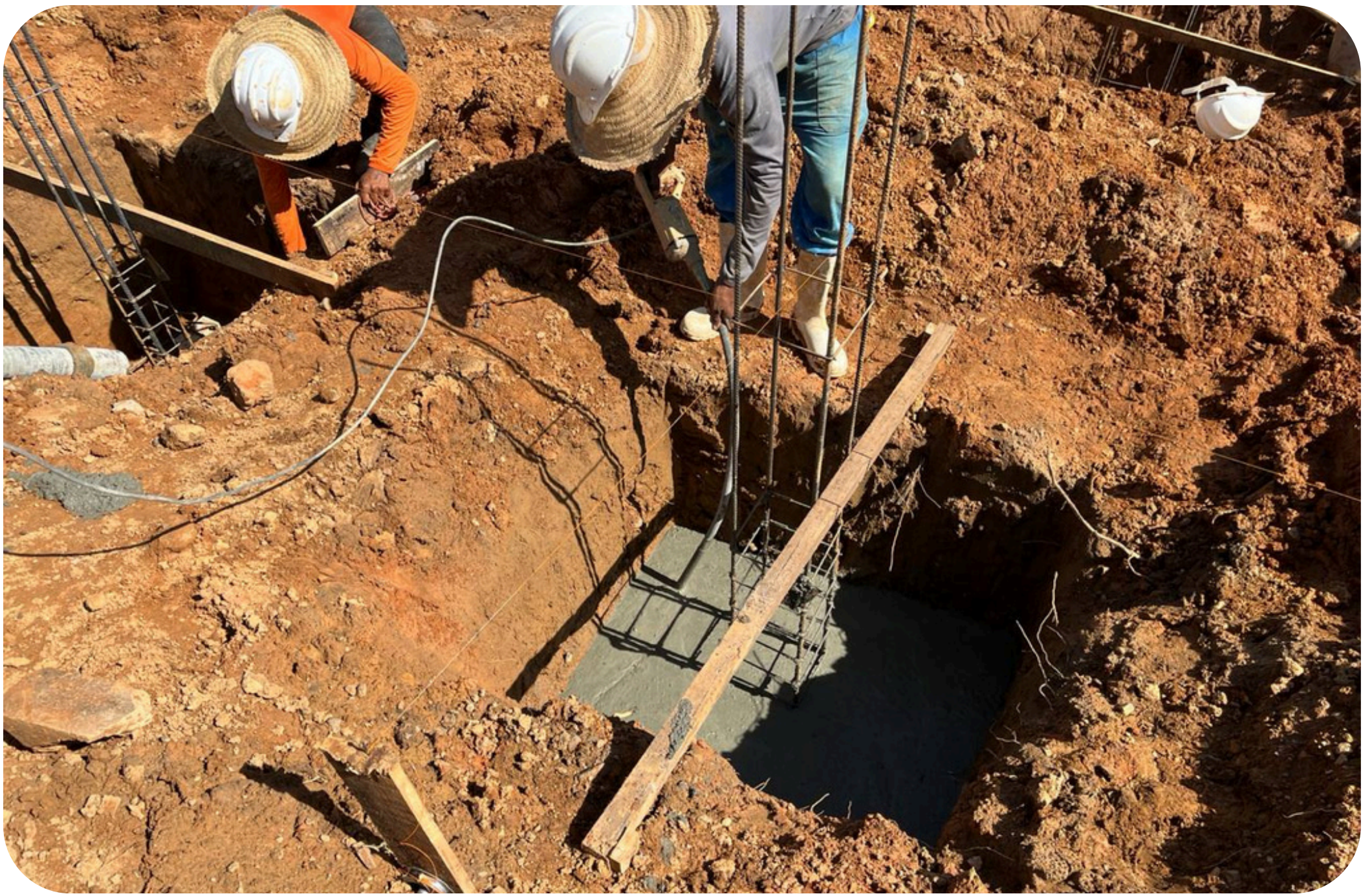
Imagem 03 - Concretagem sapatas com uso de vibrador para adensamento
